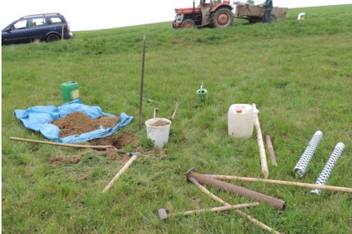
„Baustelle“ von unten
